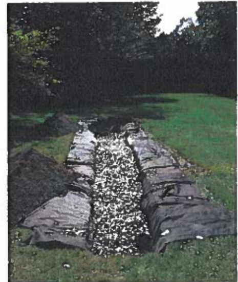
Figure 1 : Exemple de tranchée d'infiltration
